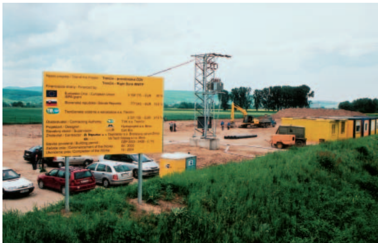
V apríli 2003 sa začali práce na čistiarni odpadových vôd v Trenčíne je prvým projektom, ktorý sa začal realizovať v rámci programu ISPA.
